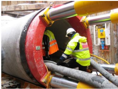
En titt in i mikrotunneln. (Täby2)
