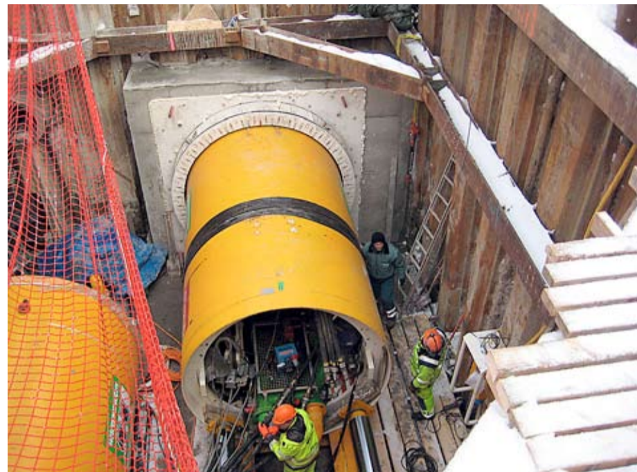
Techniken med mikrotunnelboring är ny i Sverige men vanlig utomlands. För att dra nytta av den erfarenhet som finns har man valt att ta in erfarna operatörer från tyska Herrenknecht.
